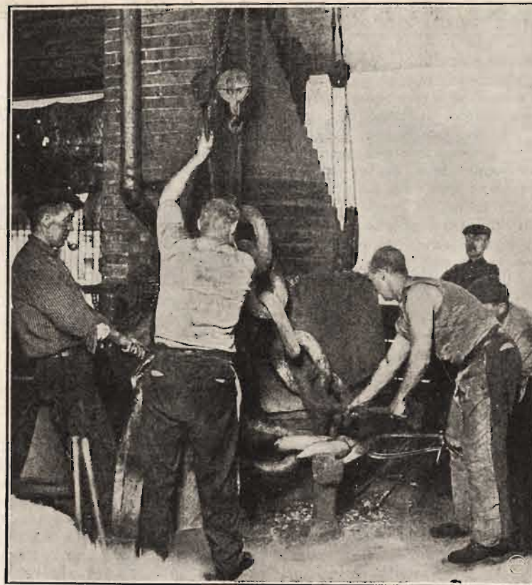
L'ultima operazione per formare un anello di catena nella lavorazione a mano: la saldatura autogena delle estremità libere e ripiegate.
